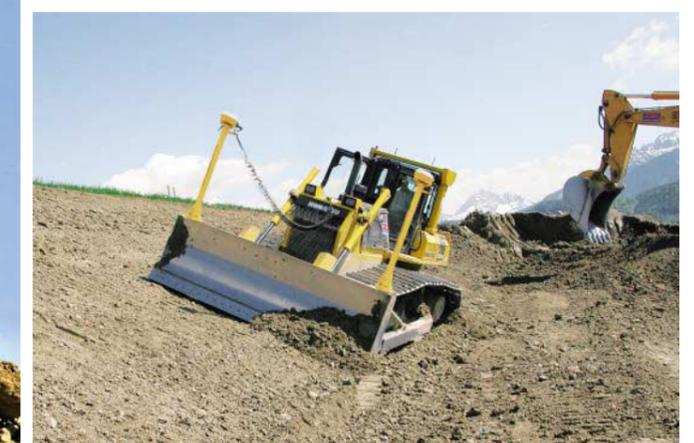
Profilieren einer Böschung im Straßenbau
